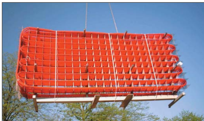
Obr. 8-22 Transportní rám REHAU BKT
