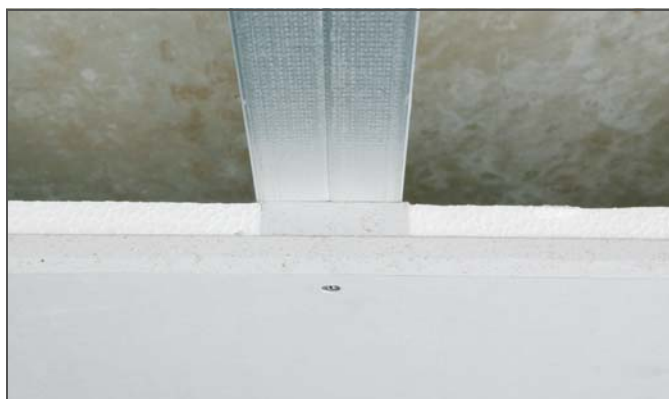
Obr. 4-6 Upevnění stropních desek
