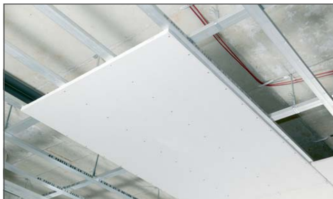
Obr. 4-5 Namontovaná stropní deska
