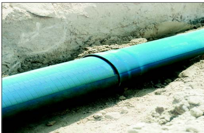
Obr. 9-32 Pokládka drenáže na hřišti
