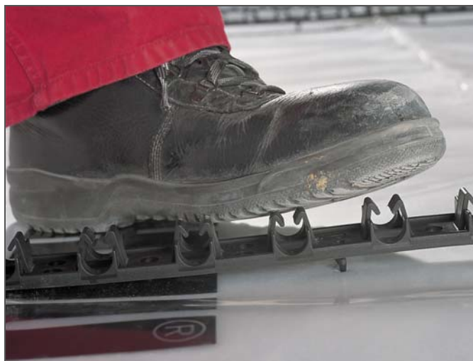
Obr. 3-39 Zatlačte vodící lištu REHAU RAUFIX do podlahové konstrukce
