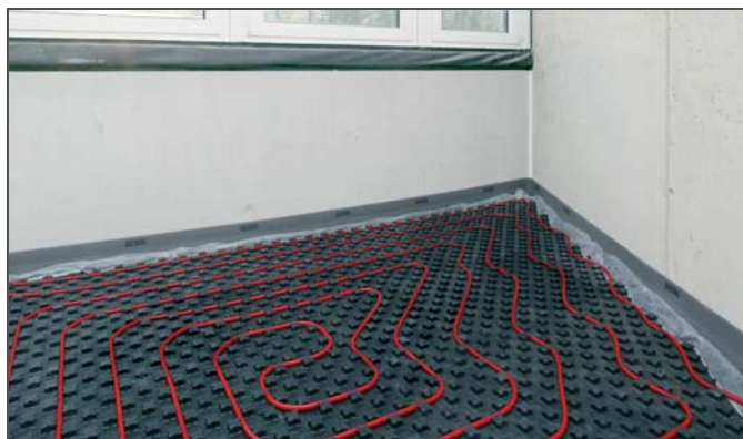
Obr. 3-11 Systém REHAU s deskou Varionova s kročejovou izolací 30-2
